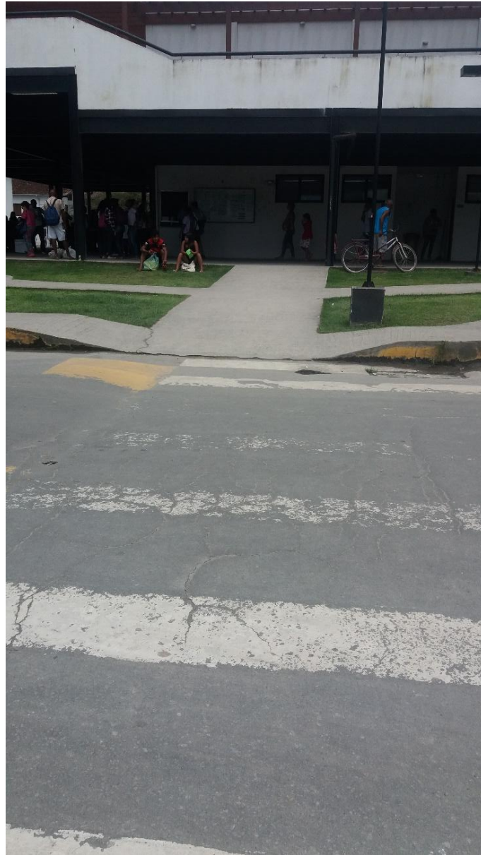
Figura 46 Rampa de acessibilidade na rodoviária de Paraty. Fonte: arquivo pessoal
