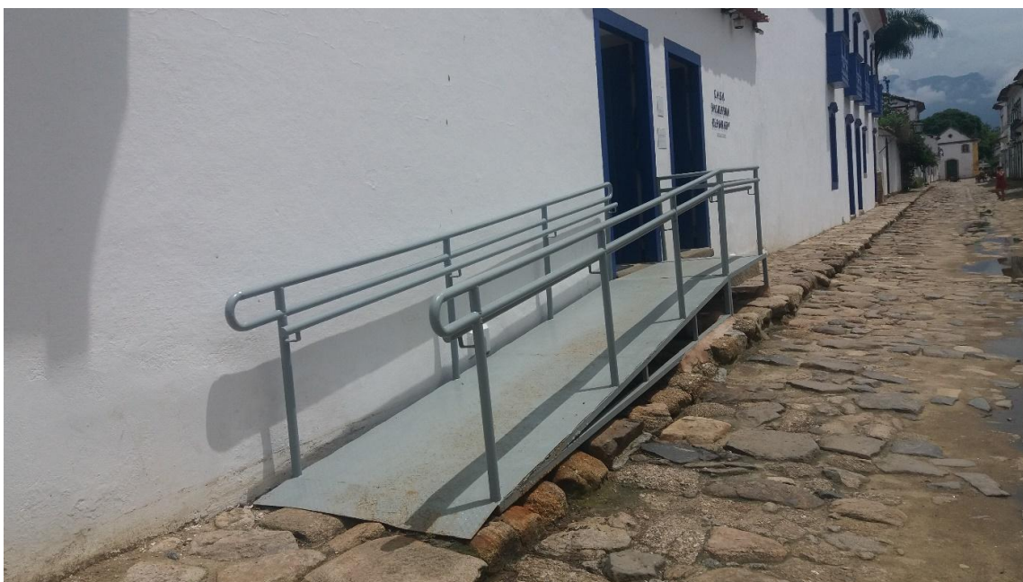
Figura 34 Casa da Cultura de Paraty: rampa de entrada. Fonte: arquivo pessoal
