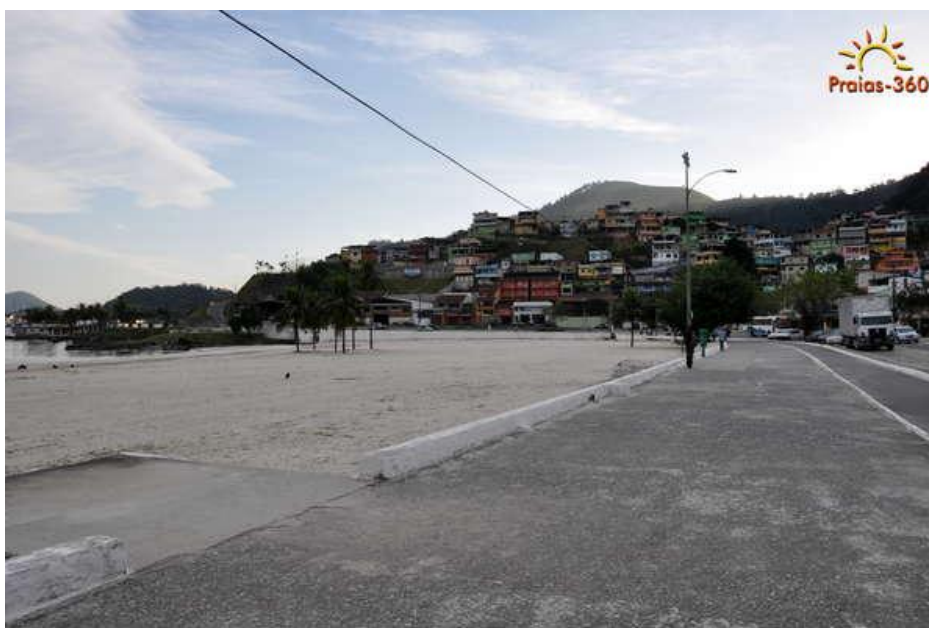
Figura 22 Calçadão da Praia do Anil, Angra dos Reis – rampa de concreto e calçadão pavimentado. Fonte: Blog Praias 360
