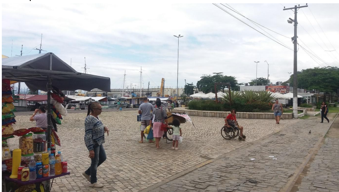
Figura 25 Calçada da estação de barcos Santa Luzia. Padrão de calçamento irregular. Fonte: arquivo pessoal
