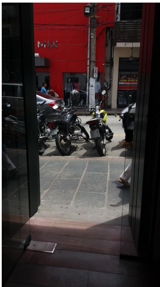
Figura 18 Casa de Cultura de Angra dos Reis. Rampa externa para acesso com cadeira de roda. Fonte: Arquivo Pessoal
