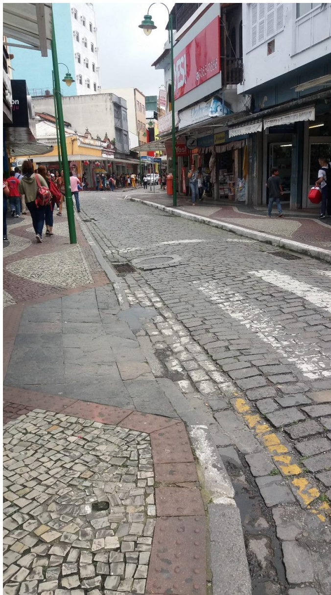
Figura 15 Avenida do Comércio, Centro, Angra dos Reis. Piso tátil e rampa para travessia em cadeira de rodas. Fonte: arquivo pessoal
