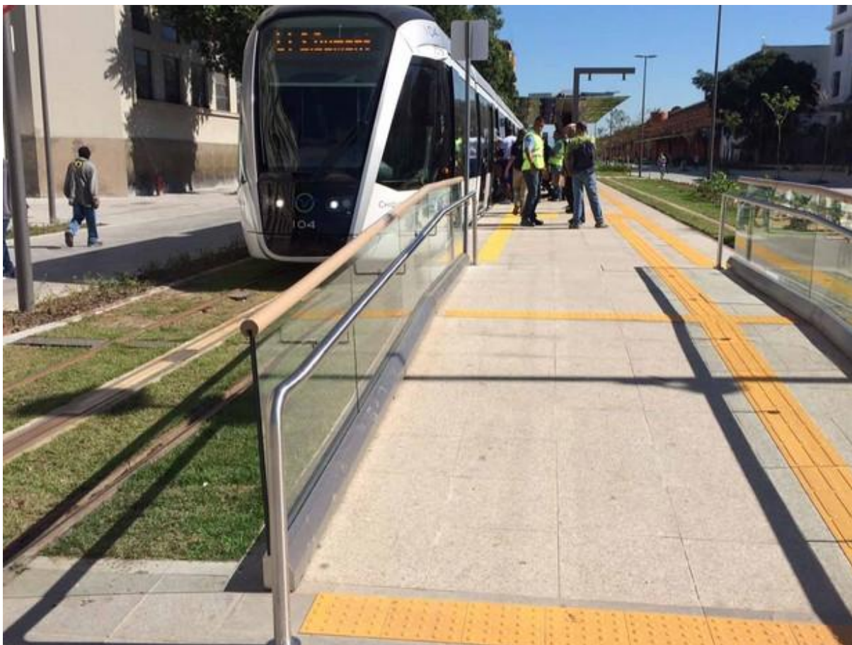
Figura 5 Estação de VLT na cidade do Rio de Janeiro: piso nivelado com plataforma, rampa, piso tátil e corrimão. Fonte: Portal G1
