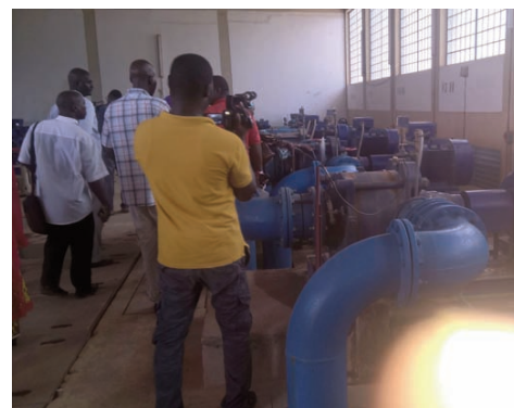
Vue partielle de l'usine de traitement
