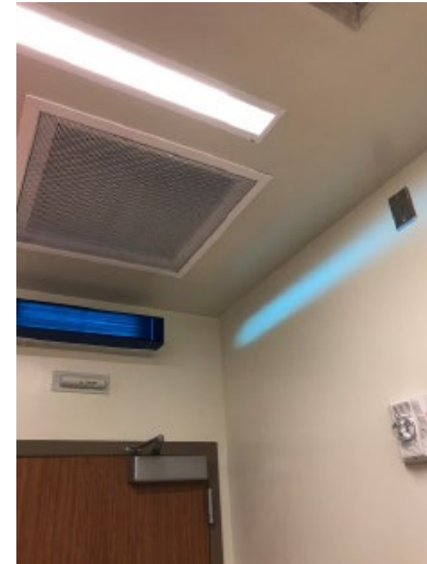
Şaşırtmalı armatürün tipik UV-C enerji modeli
