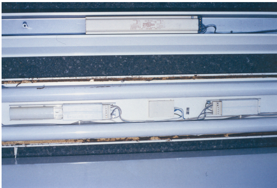
Abb. 4 Fluoreszenzlampen mit eingebauten Vorschaltgeräten. Oberes Gerät: Einbau von oben (Standardfall); Länge = 35 cm. Unteres Gerät: Einbau von unten (eher selten).
