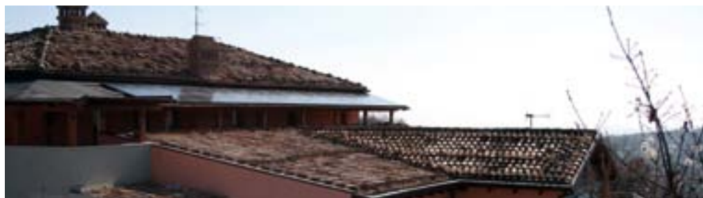
Casa autosufficiente, Comune di Penne (PE)
