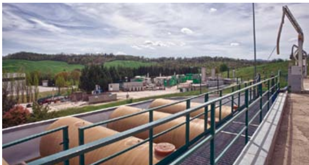
Particolare di impianto a biogas su discarica, Comune di Terranuova (AR)
