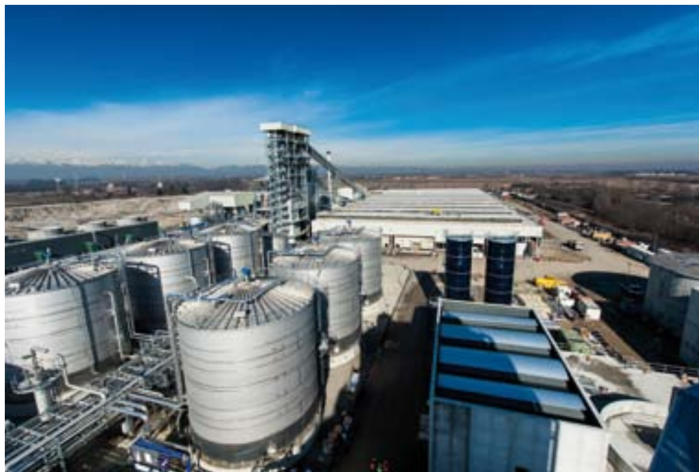
Bioraffineria nel Comune di Crescentino (VC)
