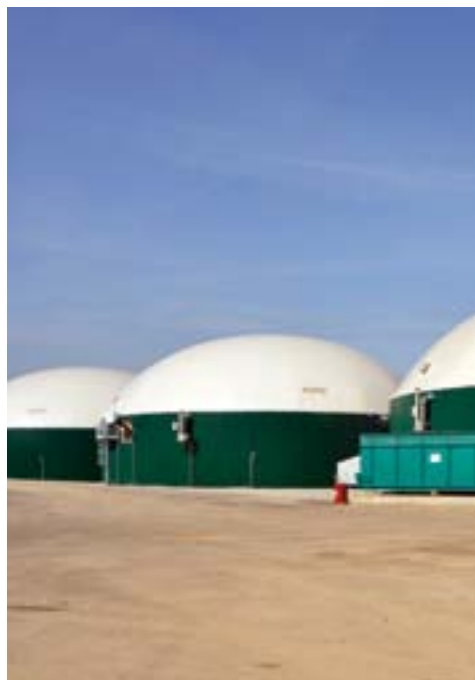
Impianto a biogas, Comune di Vottignasco (CN)
