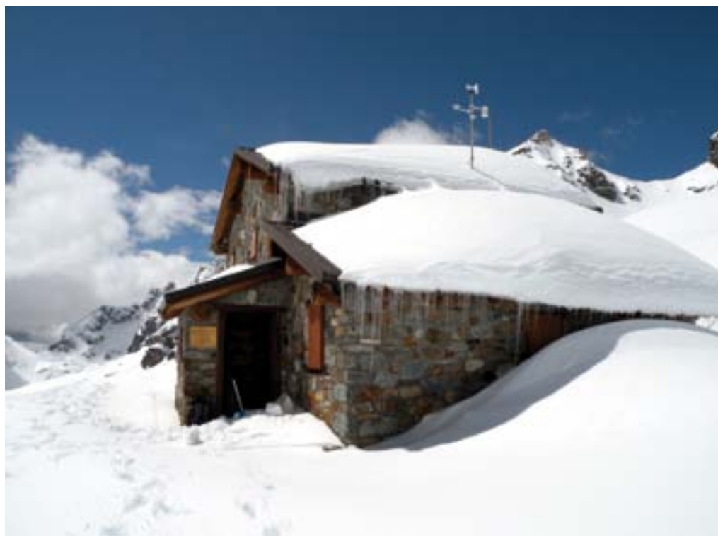
Rifugio Perrucca, servito da impianto mini idro, Comune di Valtournenche (AO)
