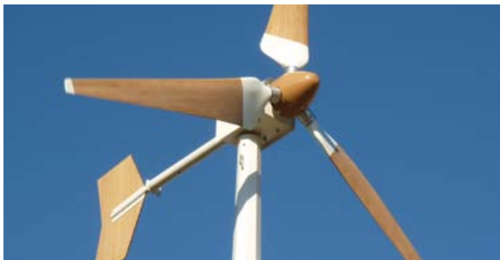
Impianto di minieolico di Farnetta, Comune di Montecastrilli (TR)
