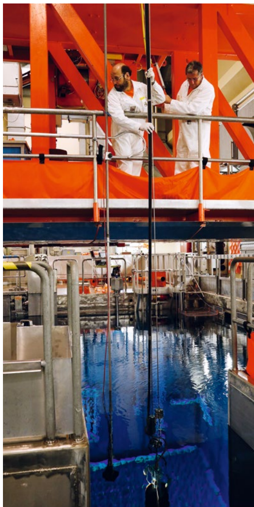
Inspektion des Brennelement-lagerbeckens. Foto: KKL
