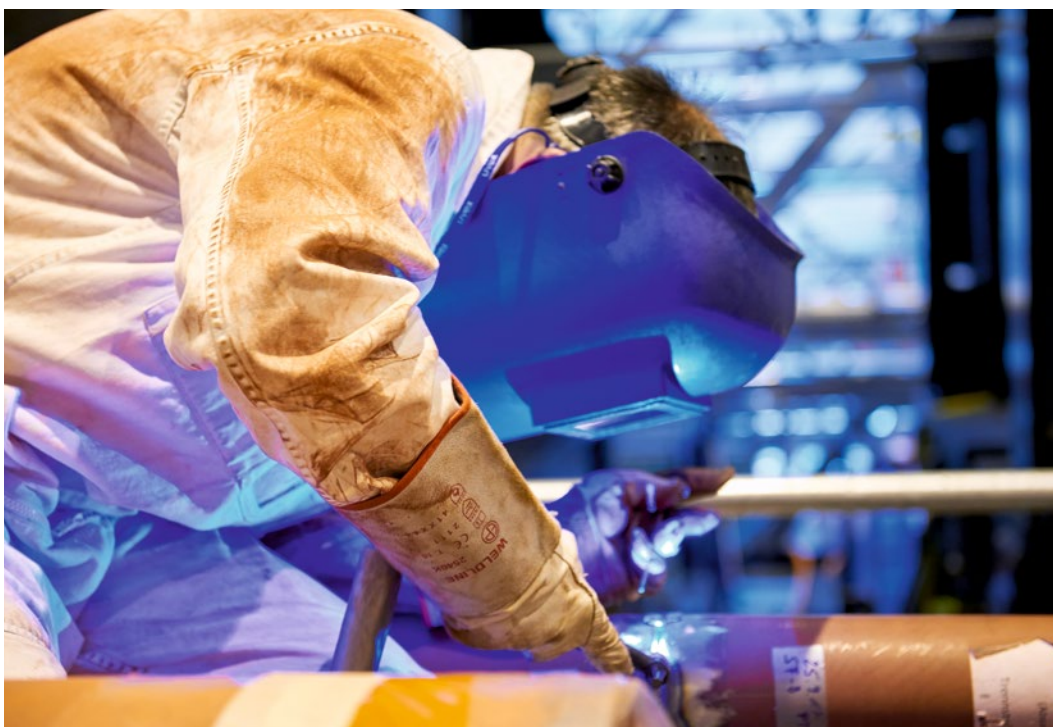
Revisionsarbeiten in der Zone II. Bild: KKL
