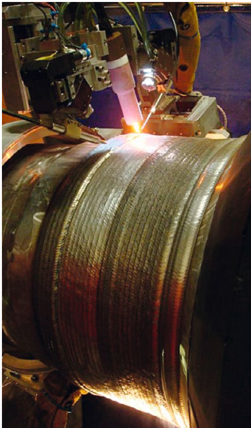
Reparatur einer Schweissnaht. Foto: KKL
