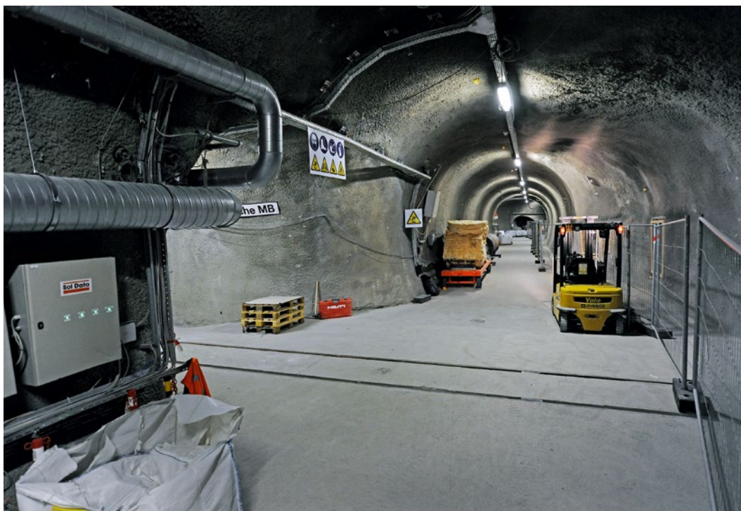
Felslabor Mont Terri. Foto: Comet
