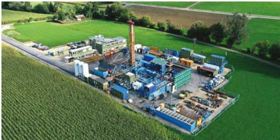
Bohrplatz Bachs. Foto: Nagra
