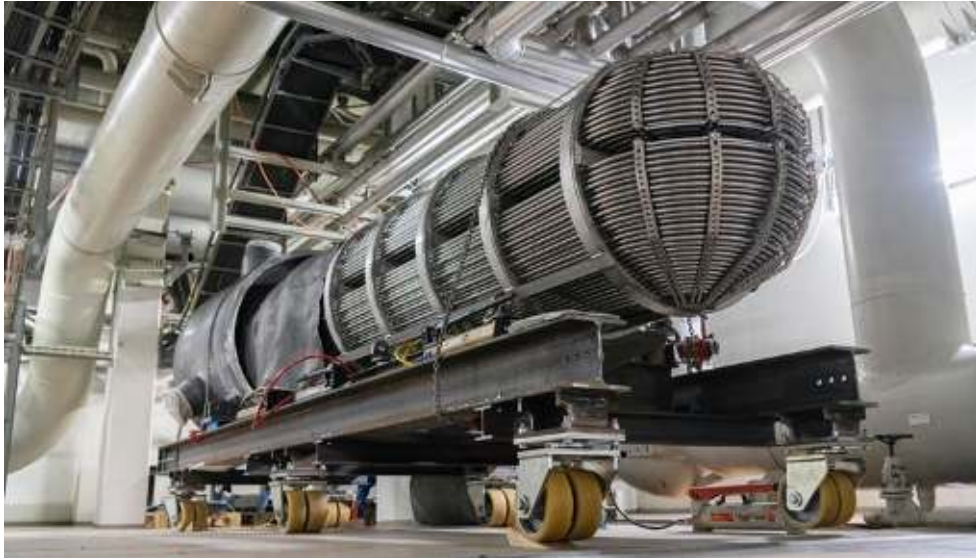
Neues Rohrbündel vor dem Einbau in einen Zwischen- überhitzer-Konden- satkühler. Foto: KKG
