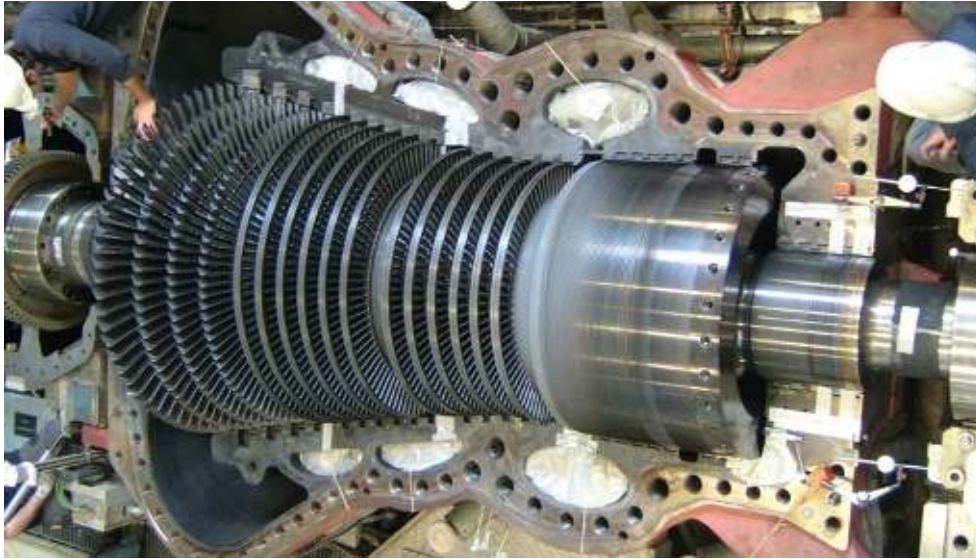
Inspektion der Hochdruckturbinen. Foto: KKB
