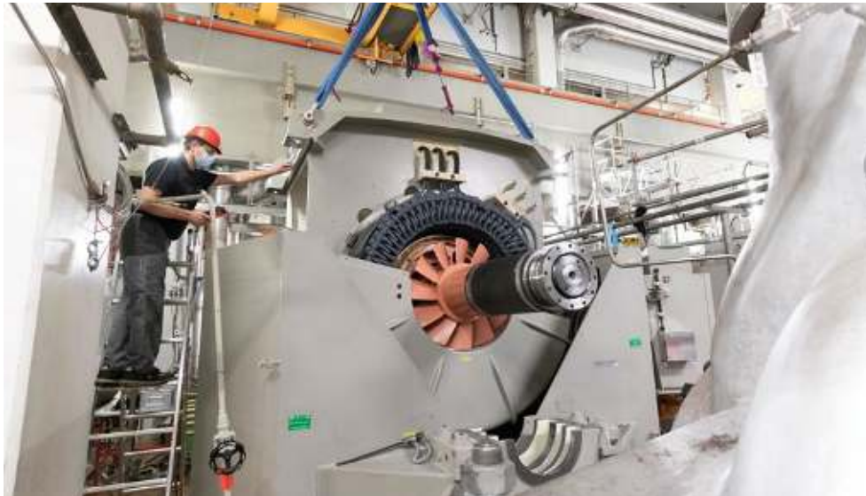
Positionieren des Einhängers ins Motorgehäuse der Hauptspeise- wasserpumpe. Foto: KKG
