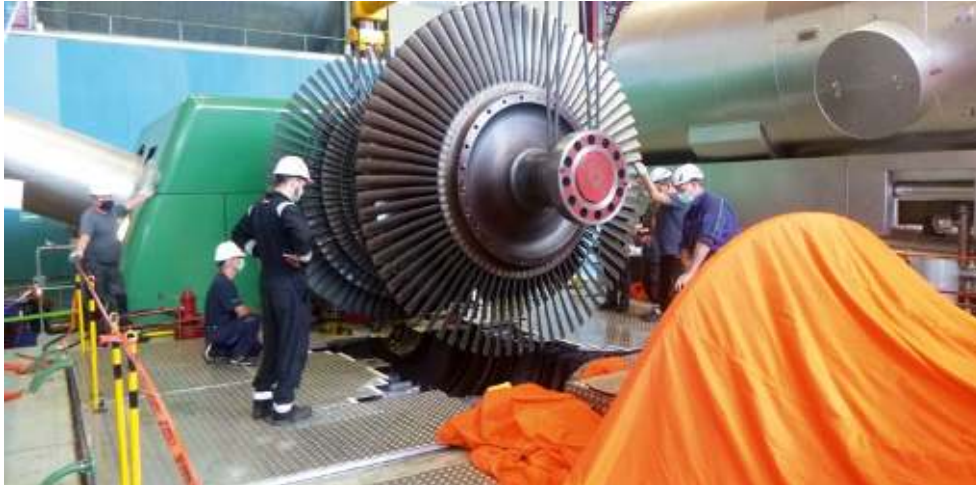
Einbau des Läufers der Niederdruck- turbine. Foto: KKB
