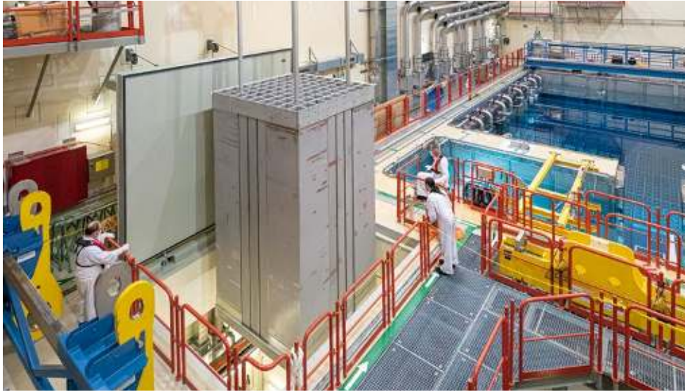
Brennelementgestell beim Einheben in das Nasslager. Foto: KKG
