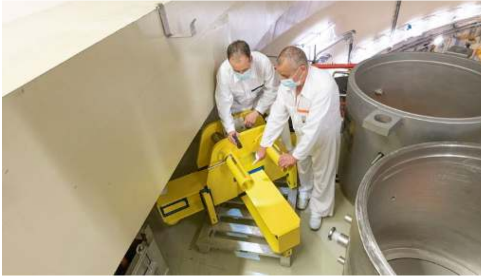
Im Ringraum des Reaktorgebäudes: Arbeitsvorbereitung für eine geplante Revision einer Traverse, die für die Demontage der Hauptkühlmittelpumpen benötigt wird.
