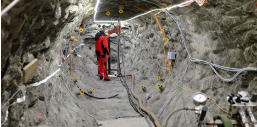
Bohrung in der Open-Twin-Nische im Felslabor Mont Terri. Foto: swisstopo
