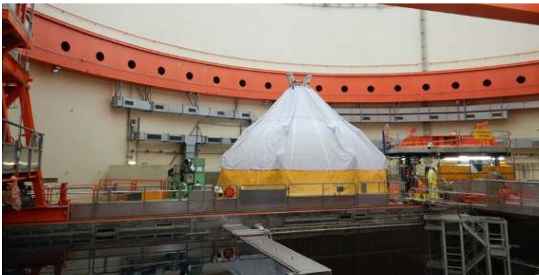
Bild 9: Zur Kontaminationsverhinderung abgedeckte Komponente während des Revisionsstillstandes.
