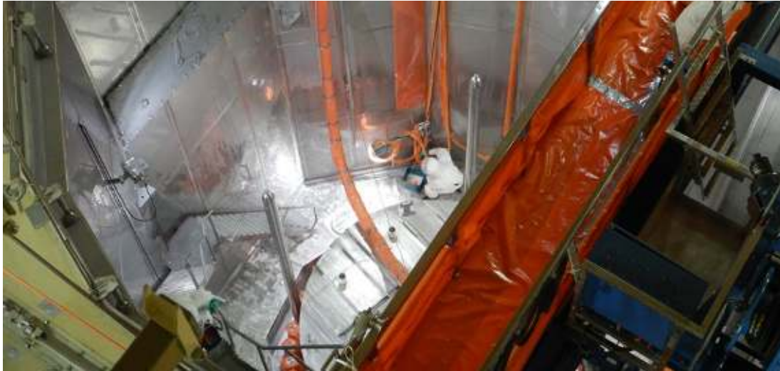
Bild 8: Reinigungs- arbeiten in der Reaktorgrube. Die Dekonta- minierungsfachkräfte arbeiten dort im Vollschutz- anzug.
