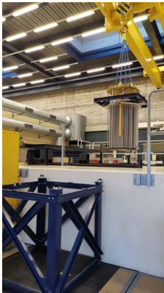
Bild 15: Transport des Reaktorkerns des CROCUS nach dem Entladen.
