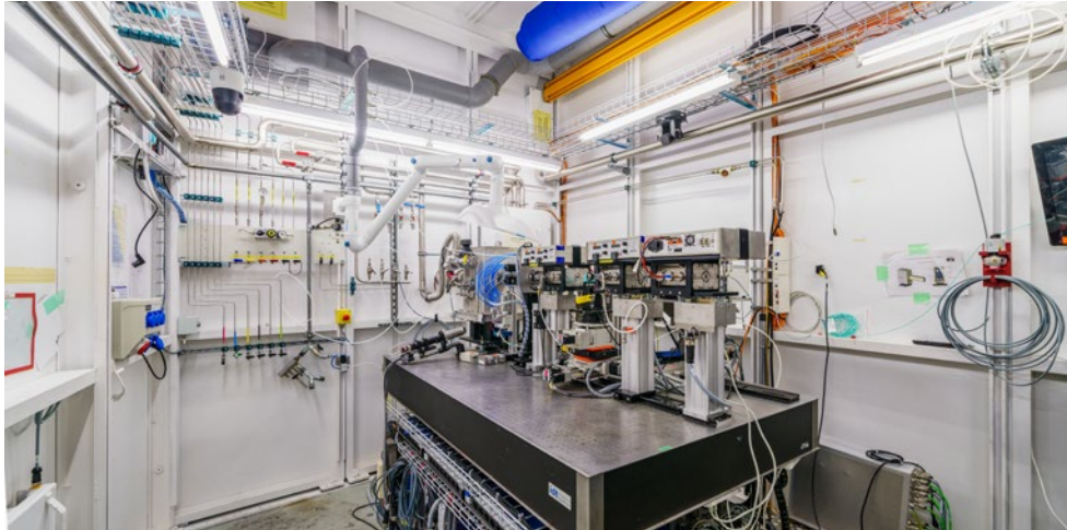
Die Grossforschungsanlage «Synchrotron Lichtquelle Schweiz». Foto: PSI
