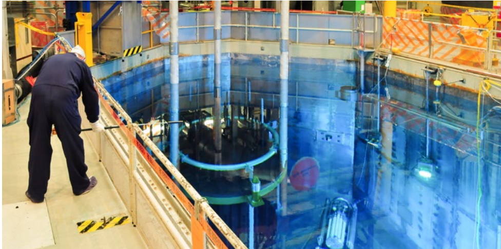
Brennelement- becken. Foto: Axpo
