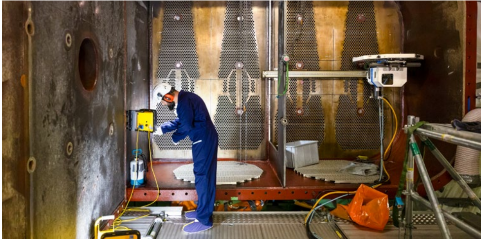
Demontagarbeiten in der Kondensation. Foto: Keystone / Peter Klaunzer
