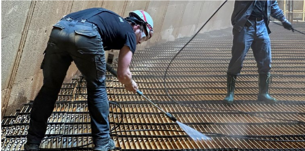
Kühlturmreinigung. Foto: KKL
