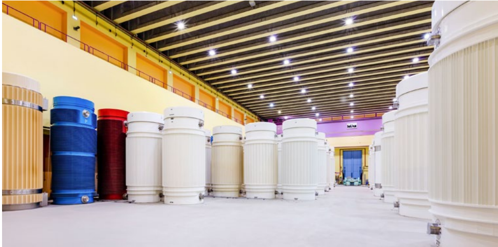
Lagehalle für hochaktive Abfälle. Foto: Zwiilag
