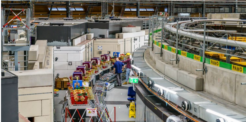
Modernisierung der «Synchrotron Lichtquelle Schweiz». Foto: PSI
