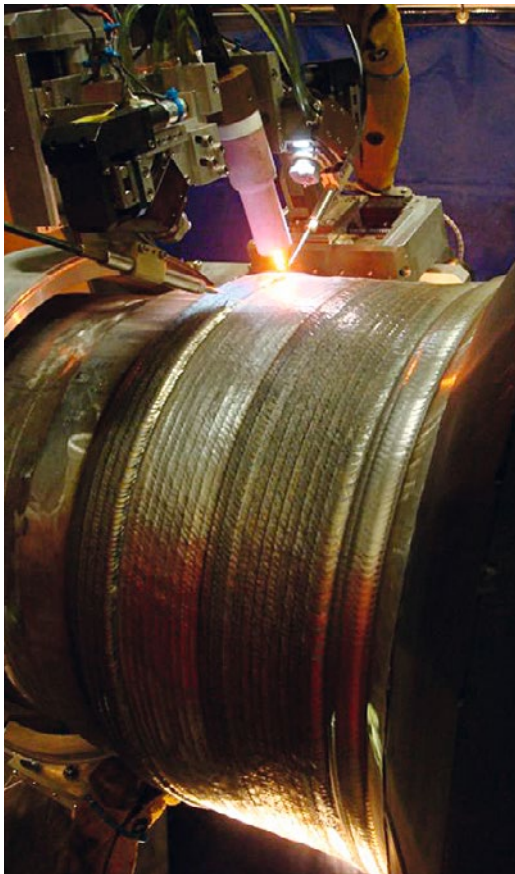
Reparatur einer Schweissnaht. Foto: KKL
