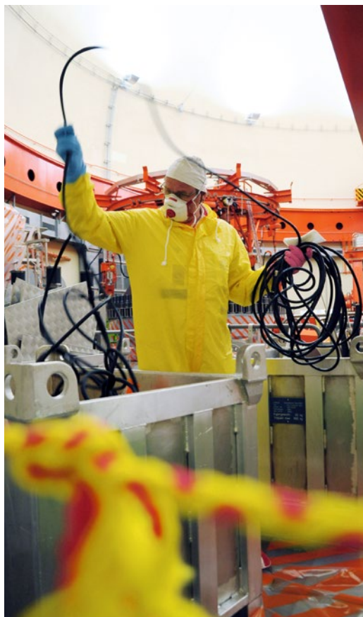
Revisionsarbeiten. Foto: KKL
