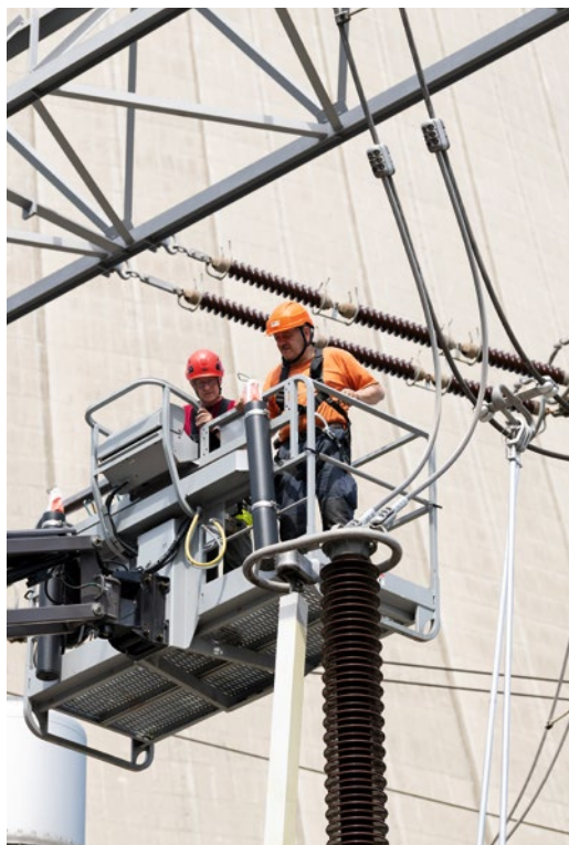
Wartungsarbeiten am 380-kV-Netz. Foto: KKG
