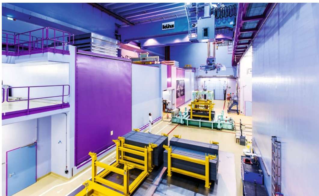
Empfangshalle E. Foto: Zwiilag
