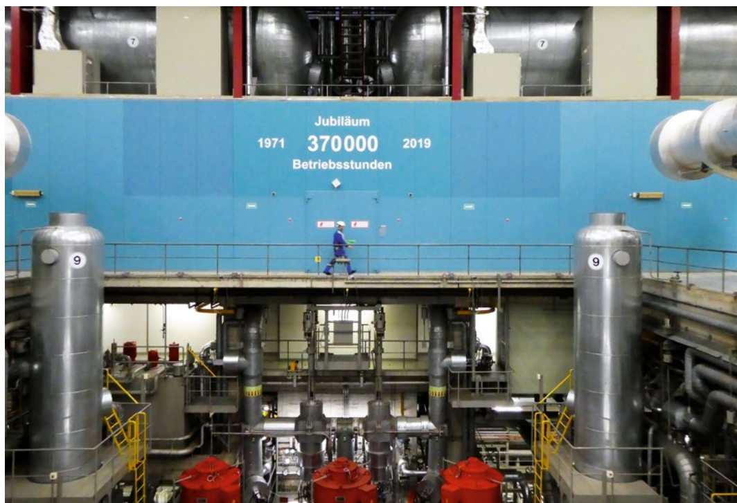
Maschinenhaus. Foto: KKB
