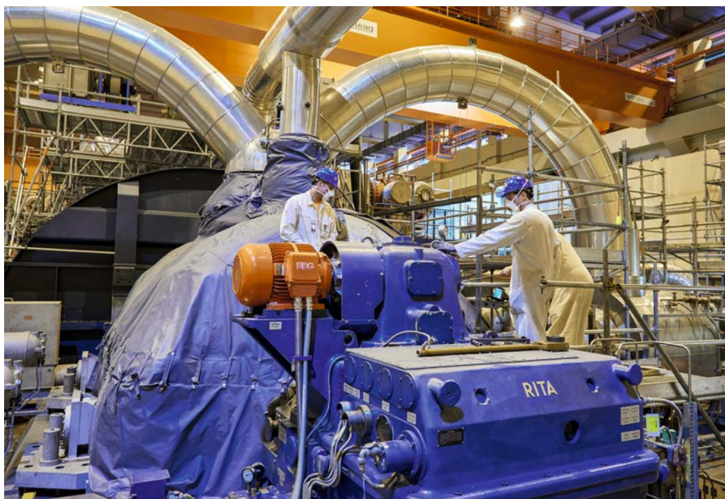
Revisionsarbeiten an der Turbine. Foto: KKL
