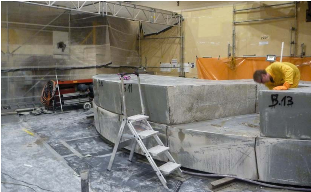
Entfernung der Abdecksteine oberhalb des Reaktors. Foto: KKM
