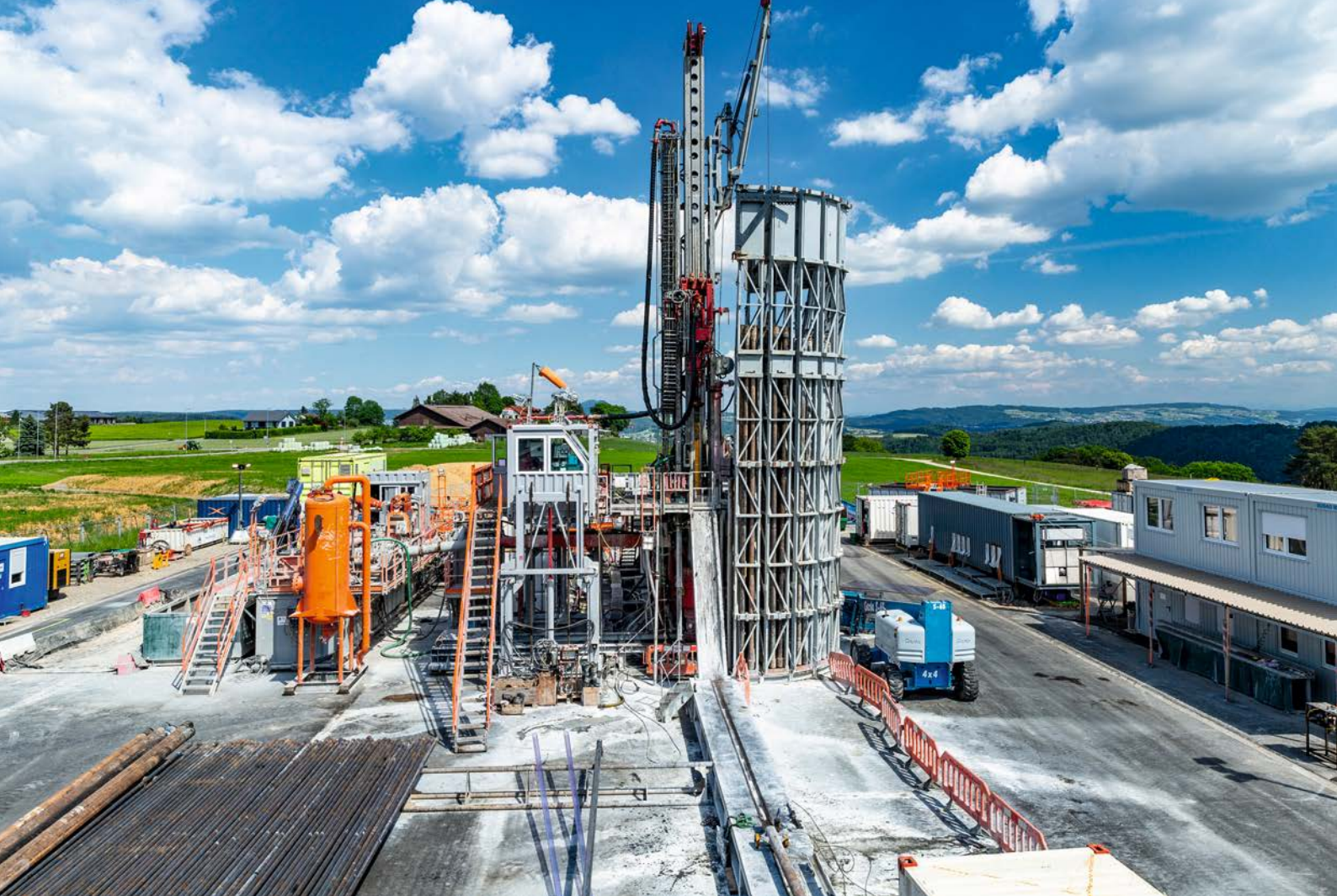
Bohrplatz Bözberg 1. Foto: Nagra
