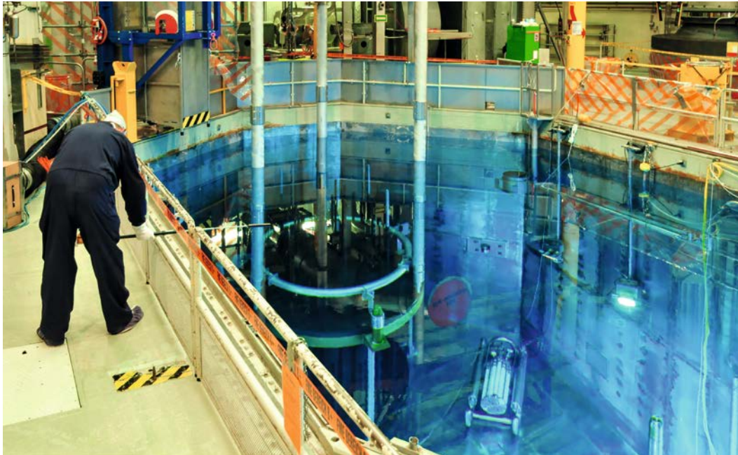
Brennelementbecken: Inspektionsarbeiten während der Revision. Foto: KKB
