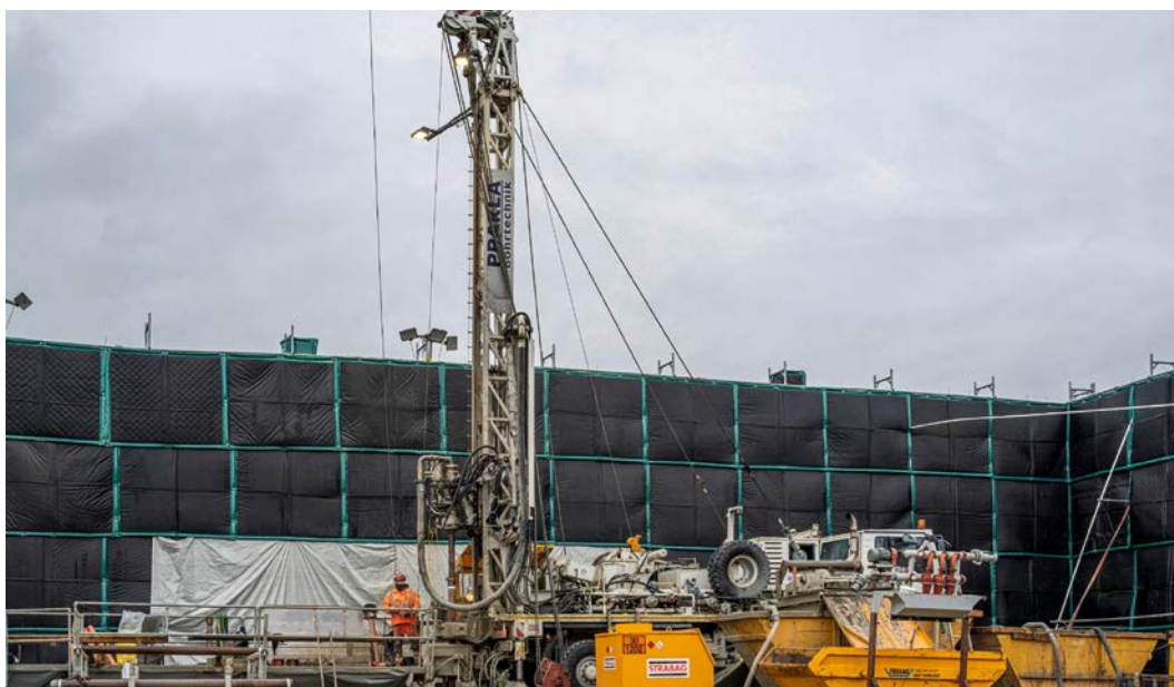
Quartärbohrung in Adlikon-Dätwil. Foto: Nagra
