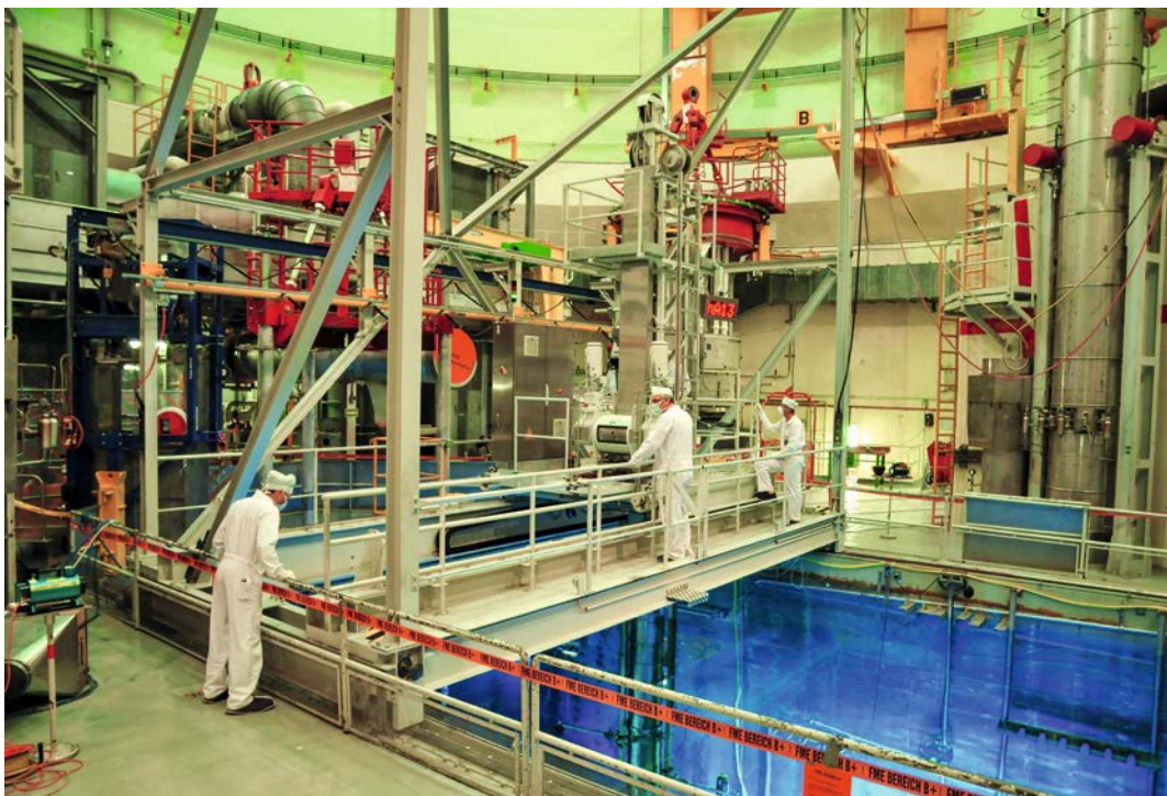
Inspektionsarbeiten während der Revision. Foto: KKB
