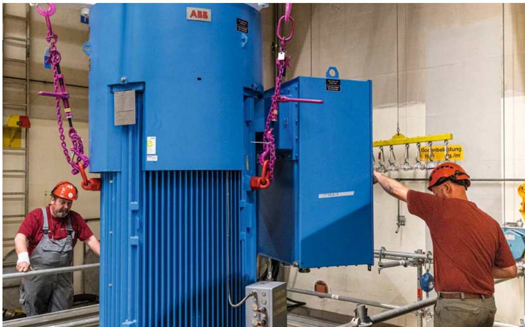
Revision der zweiten Wasserfassung: Setzen des neuen Elektromotors. Foto: KKG
