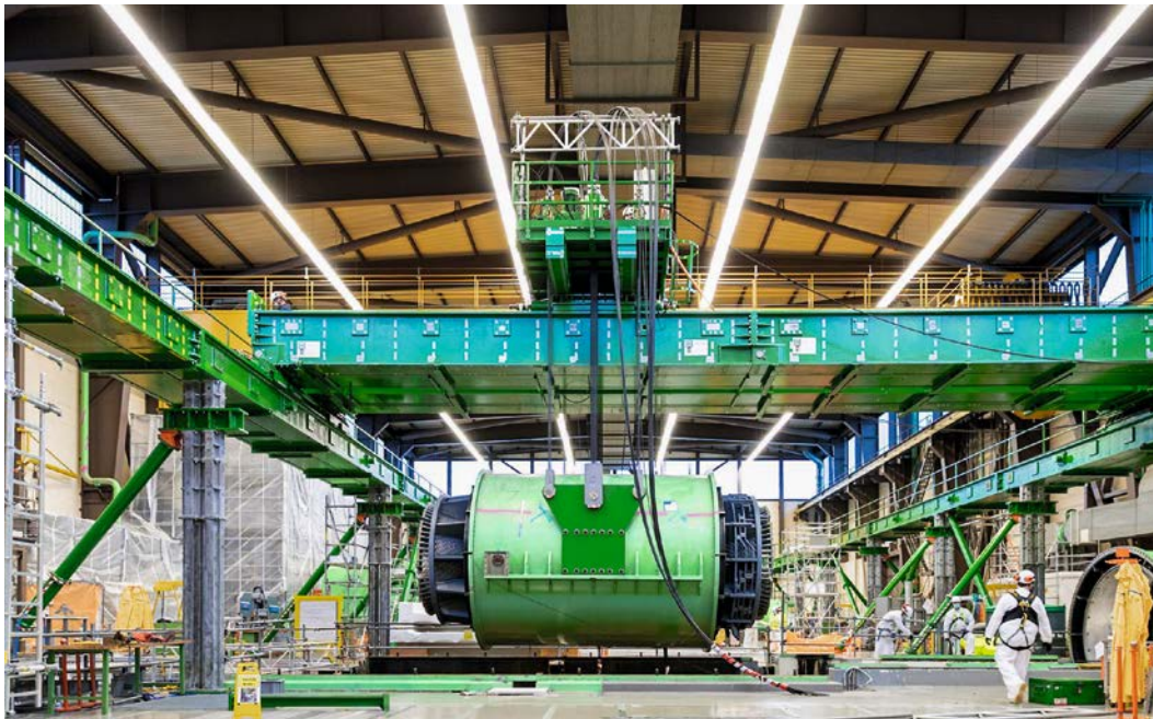
Aushub des Generator-Stators. Foto: KKM
