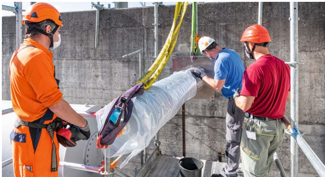
Austausch einer Wanddurchführung bei den Blocktrans- formatoren. Foto: KKG
