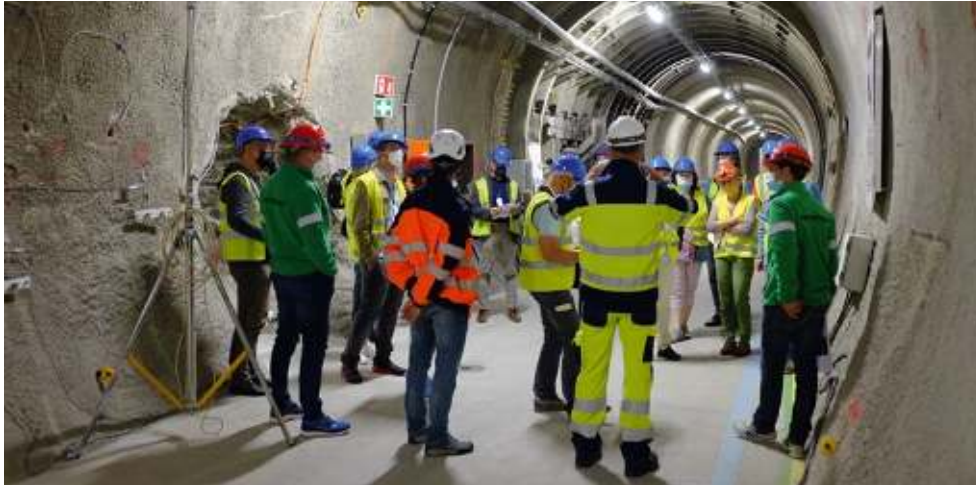
Besuch des Felslabors Mont Terri während eines Seminars. Foto: Nagra
