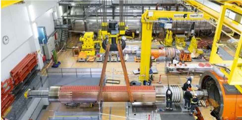
Generatorrevision: Beim Ziehen des Rotors ist Finger- spitzengefühl gefragt. Foto: KKG
