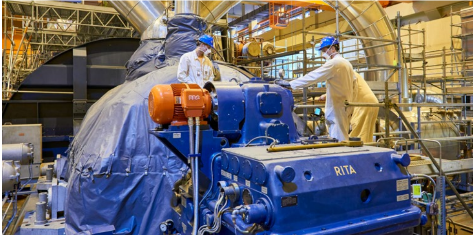
Revisionsarbeiten an der Turbine. Foto: KKL
