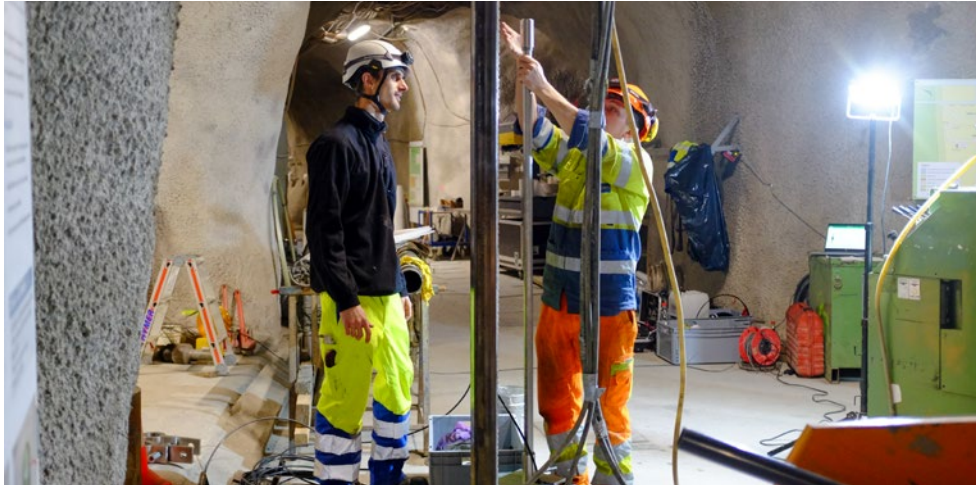
Arbeiten im Felslabor. Foto: swisstopo
