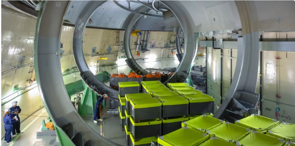
Demontagerbeiten im Torus. Foto: Keystone / Peter Klaunzer
