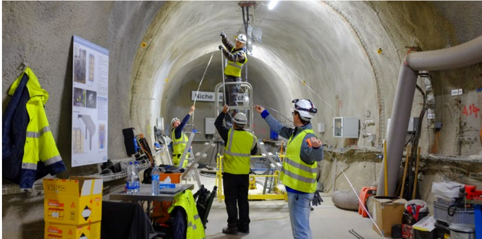
Arbeiten im Felslabor Mont Terri. Foto: swisstopo
