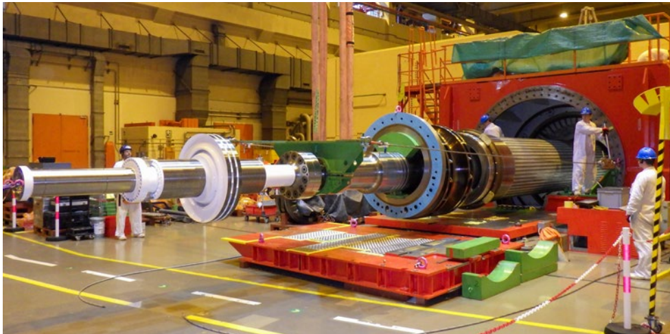
Einsetzen des Rotors in den Generator. Foto: KKL
