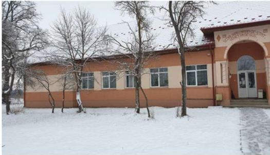
Fig. 7. Reference building - Venetia de Sus
